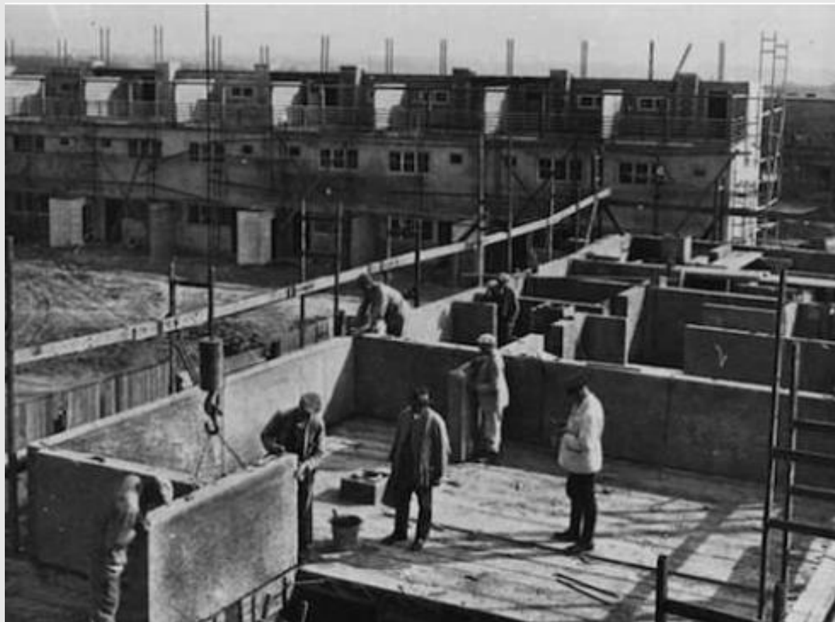
Construção em Praunheim em 1926
