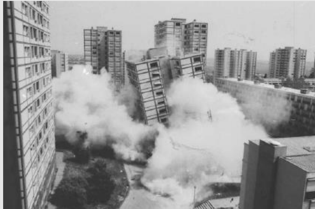
Demolição de um edifício no Minguettes em Lion
