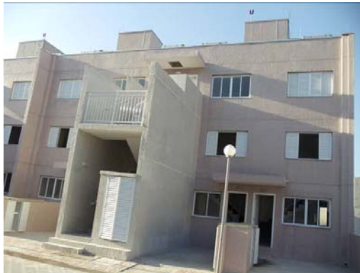
Figura 9 – Vista externa da tipologia SB22. Fonte: Acervo próprio, 04 jul. 2012.
