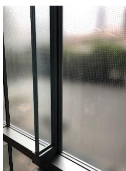
Figura 17: Detalhe da fachada
