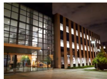
Figura 25: Edifício do Centro Tecnológico – fachada oeste
