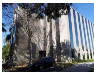
Figura 24: Edifício do Centro Tecnológico – fachadas norte e oeste
