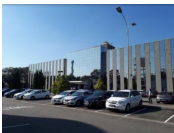
Figura 23: Edifício do Centro Tecnológico – fachada oeste
