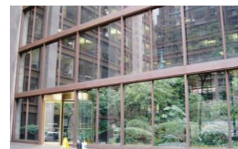
Figura 5: Átrio de um edifício comercial
