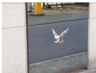
Figura 26: Detalhe adesivo de água aplicado à fachada
