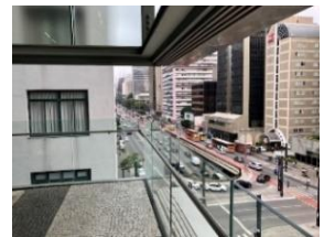
Figura 22: Detalhe da quina
