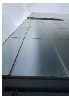
Figura 18: Detalhe da fachada
