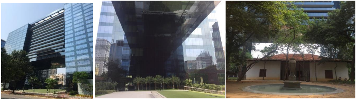
Figura 13: Fotos do Edifício Pátio Victor Malzoni. Fonte: Acervo Próprio
