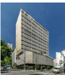
Fig. 73- Oswaldo Bratke: Edifício Renata Sampaio, São Paulo, Brasil, 1956.
