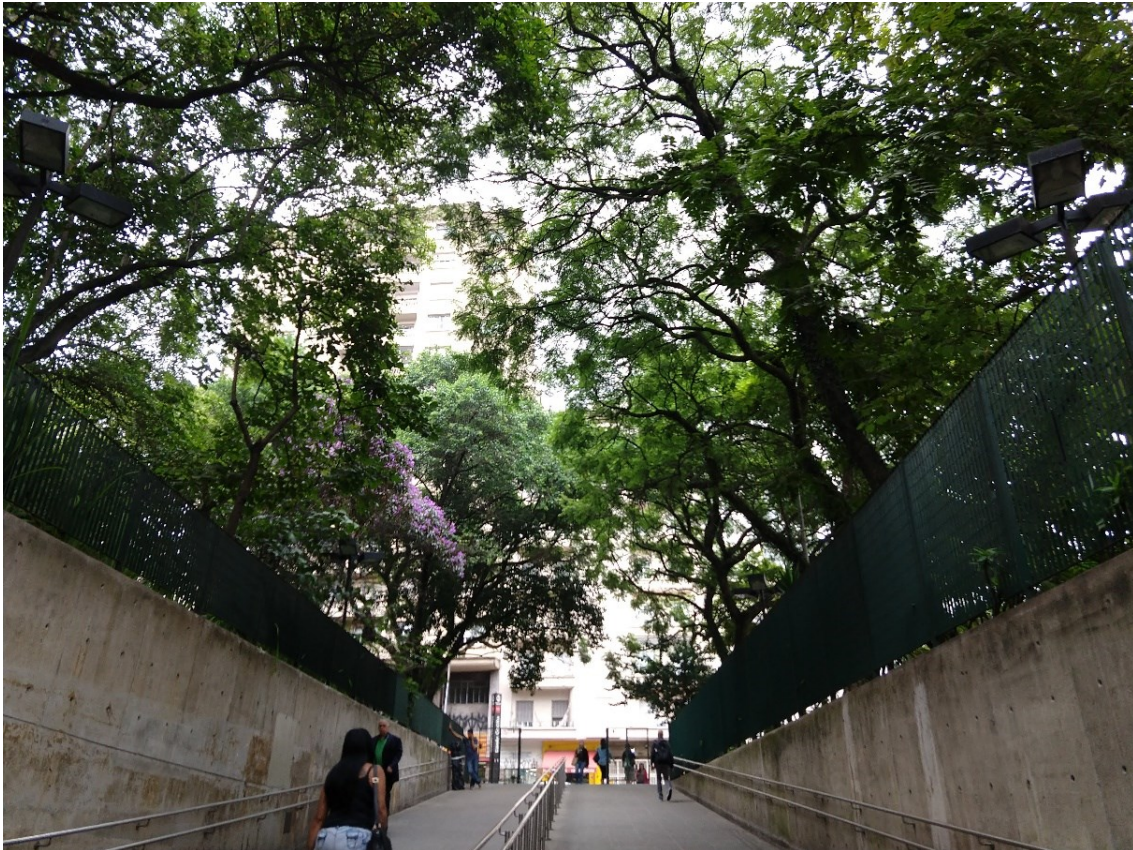
Figura 2 Acesso à Estação pela Rua Ana Cintra, dentro da praça construída pela Emurb. Fonte: Acervo pessoal, 2019.
