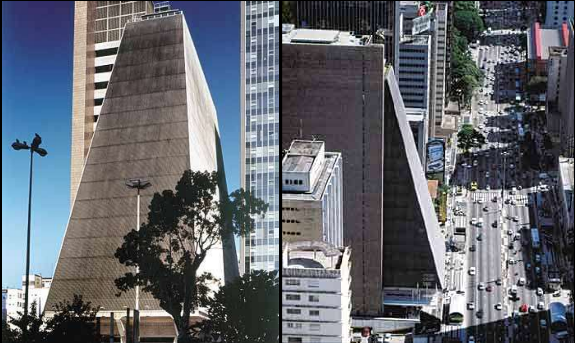
FIESP – 1969/79 – Roberto Cerqueira Cesar – reabilitação Paulo Mendes da Rocha - estrutura metálica parasita
