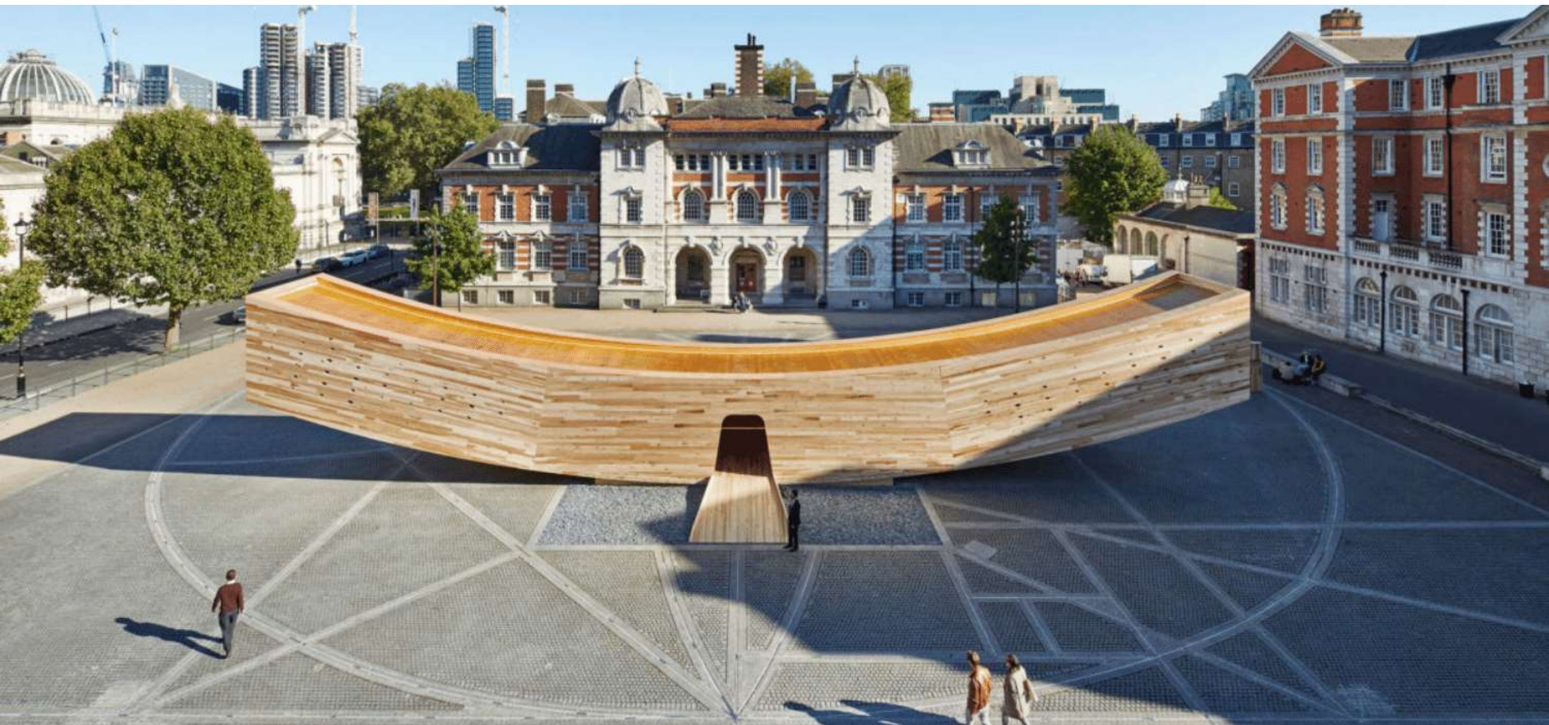
O pavilhão Smile foi construído para o London Design Festival 2016 para mostrar o potencial estrutural e espacial da madeira laminada cruzada | Fonte da foto Alison Brooks Architecture
