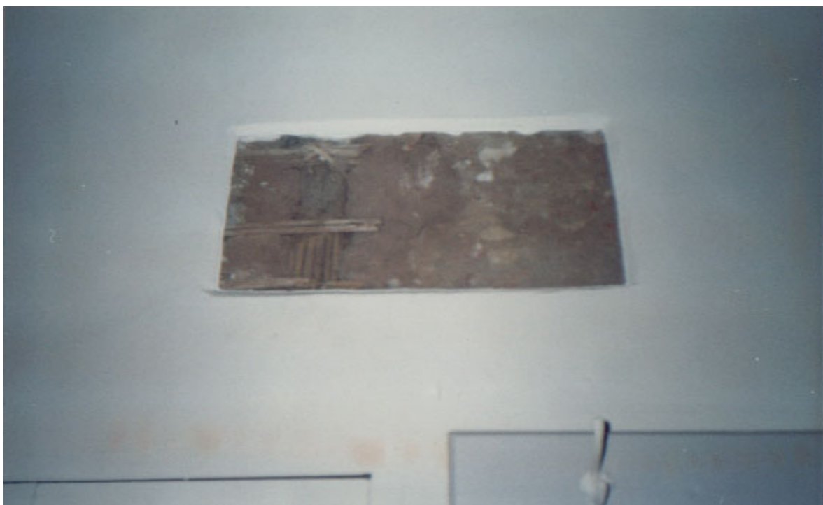
Foto 3 – “janela” mostrando a taipa de mão abaixo do revestimento recuperado
