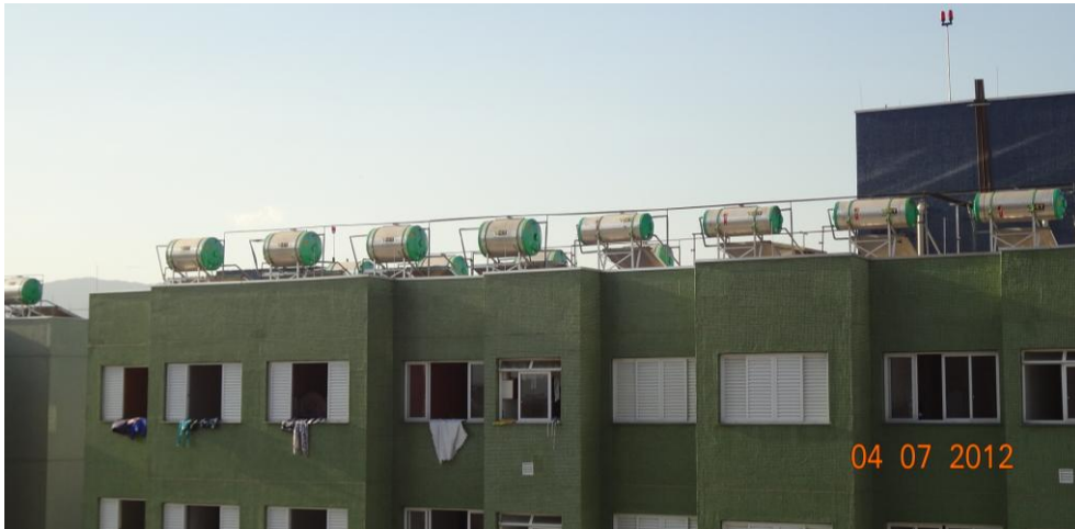
Figura 2.8.3 Aquecedores solares. Foto: Erica Lemos Gil.
