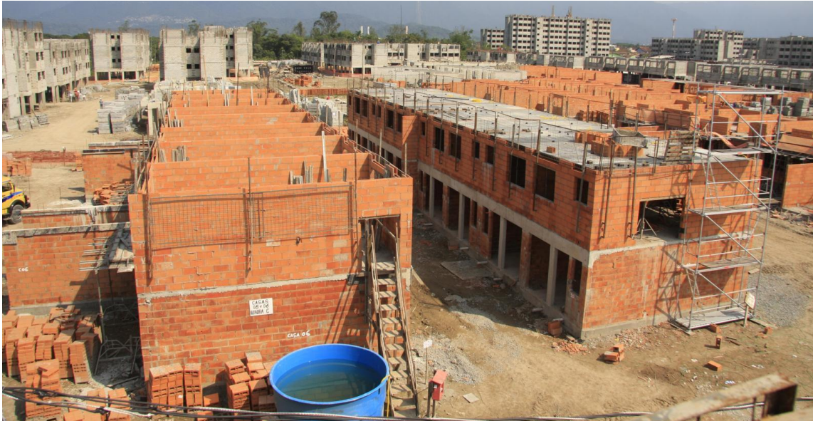
Figura 2.9.4 Edifícios com blocos de concreto e cerâmicos. Fonte: Deangelo Fotos: RUBENS LARA. Disponível em: http://deangelofotos.blogspot.com.br/2010/11/rubens-lara.html . Acesso em 02/05/2012.
