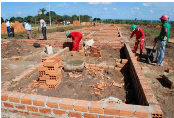
Figura 3.2.1 Início das obras Fonte: Imagem cedida pela Construtora Staff (2010)
