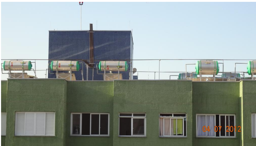
Figura 2.8.4 Aquecedores solares. Foto: Erica Lemos Gil.
