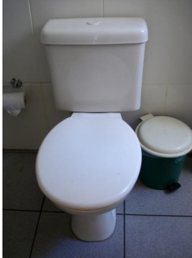
Figura 2.11.5: Bacia com caixa de descarga acoplada. Foto: Maria Augusta Justi Pisani
