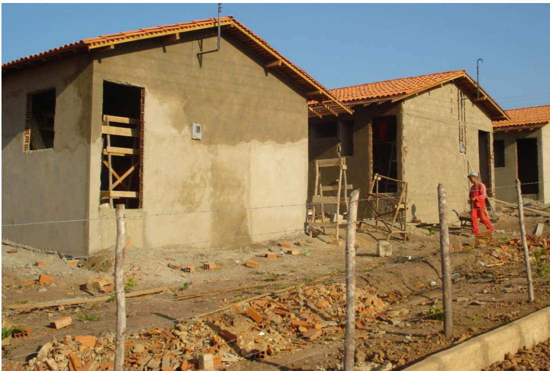
Figura 3.8.5 Resíduos reutilizados na construção. Fonte: ADH (julho/2009)
