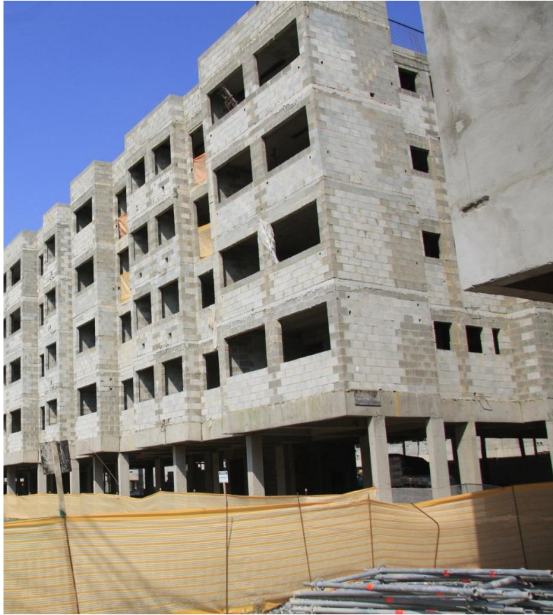
Figura 2.9.9 Lajes, pilares e vigas moldados in loco. Fonte: Deangelo Fotos: RUBENS LARA. Disponível em http://deangelofotos.blogspot.com.br/2010/11/rubens-lara.html . Acesso em 02/05/2012.
