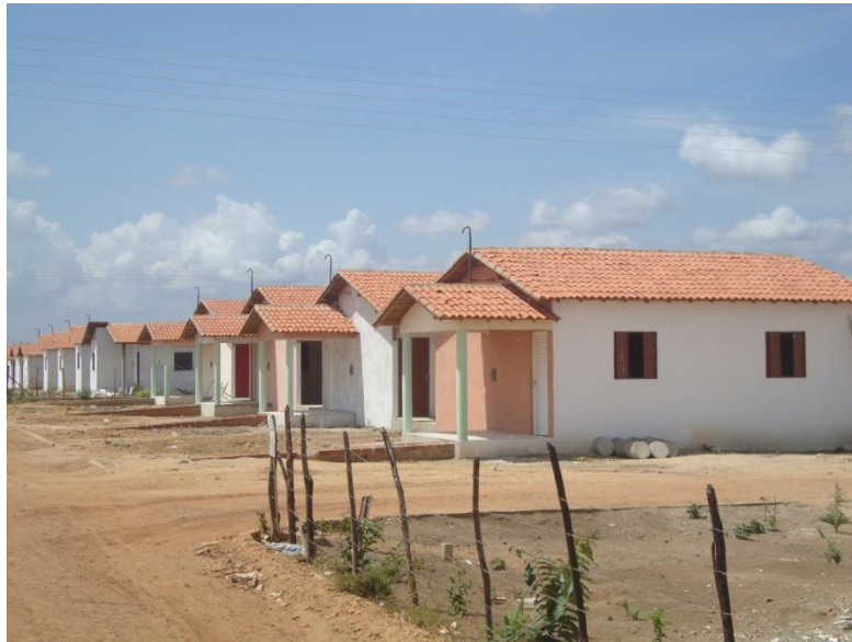
Figura 3.3.2 Vista do residencial. Fonte: ADH, mar. 2012.
