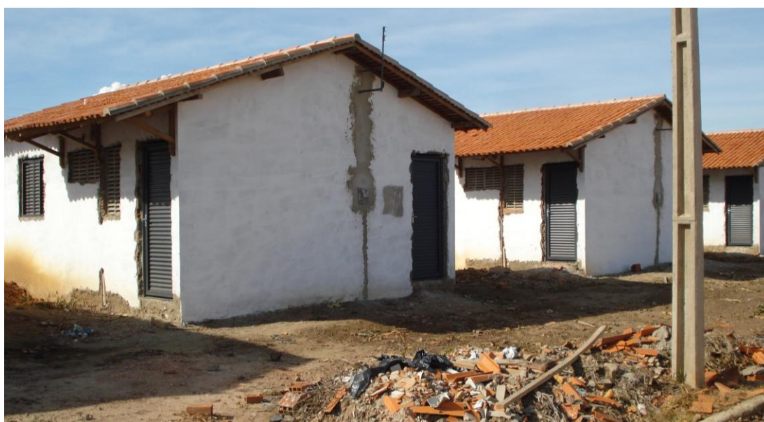
Figura 3.8.1 Quebras para adequação de aberturas à alvenaria executada. Fonte: ADH (maio/2010)
