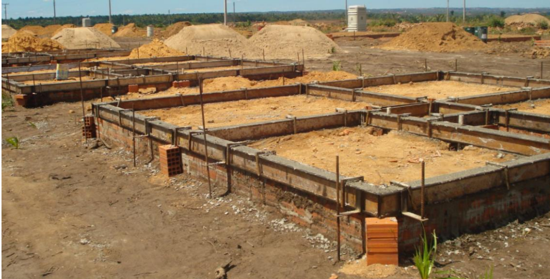
Figura 3.8.4 Utilização de formas metálicas. Fonte: ADH (julho/2009)
