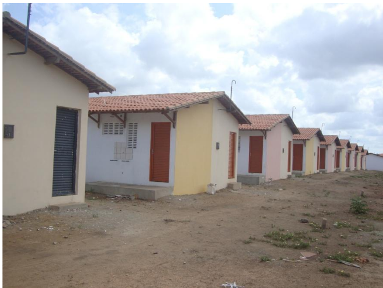
Figura 3.3.1 Vista do residencial. Fonte: ADH, mar. 2012.
