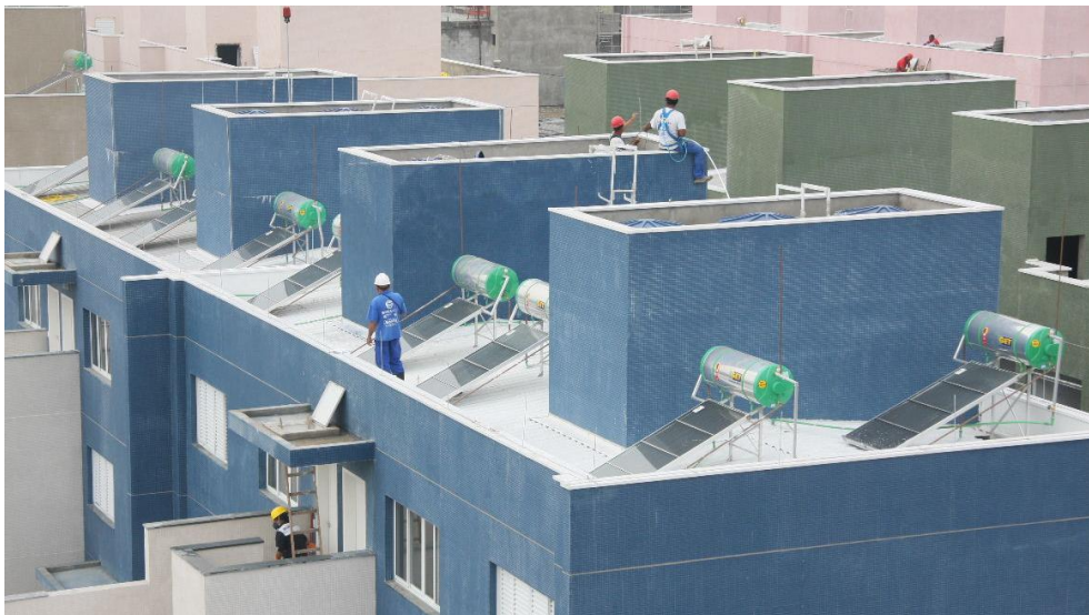
Figura 2.8.4 Aquecedores solares. Foto: Erica Lemos Gil.
