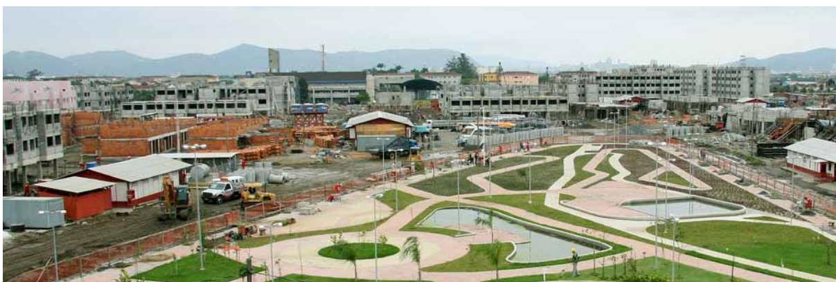
Figura 2.9.17 Canteiro de obras do Conjunto Rubens Lara. Fonte: Deangelo Fotos: RUBENS LARA. Disponível em: http://deangelofotos.blogspot.com.br/2010/08/rubens-lara.html . Acesso em 02/05/2012.
