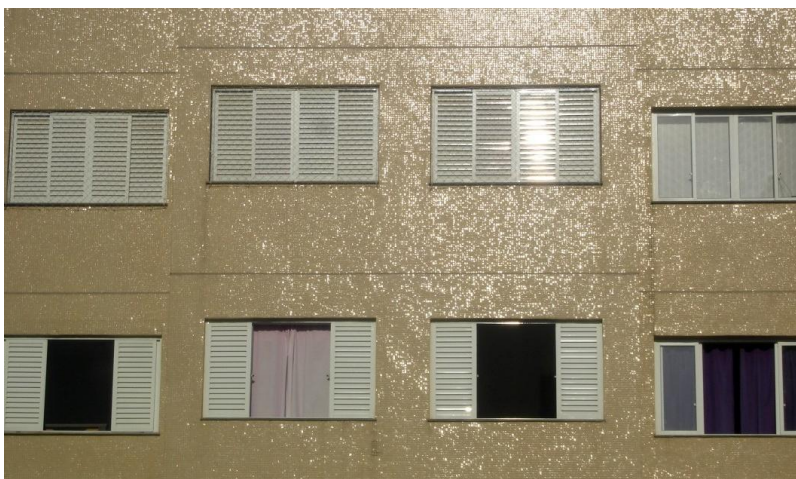
Figura 2.9.12 Caixilhos de alumínio. Foto: Maria Augusta Justi Pisani
