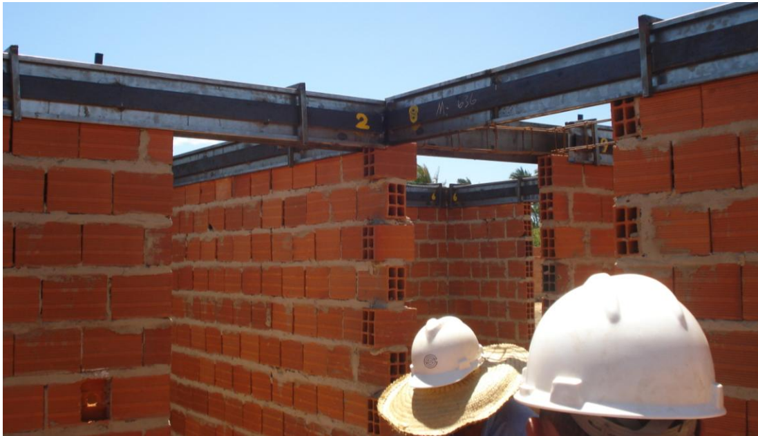
Figura 3.8.2 Argamassa de assentamento com espessuras variadas. Fonte: ADH (agosto/2009)
