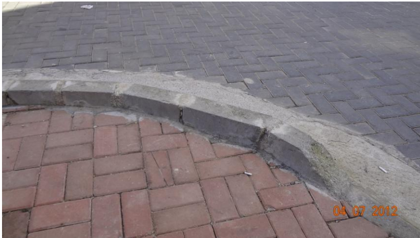
Figura 2.9.8 Pavimento de Blocos de concreto intertravado. Foto: Erica Lemos Gil
