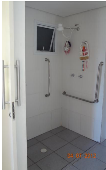
Figuras 2.9.15 Revestimentos cerâmicos. Foto: Erica Lemos Gil
