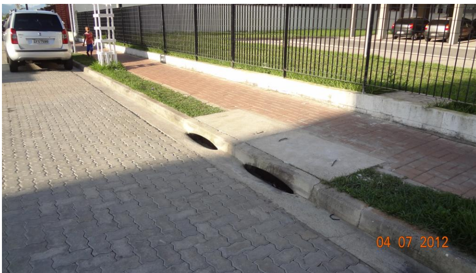
Figura 2.11.2 Pavimento com blocos intertravados de concreto, passeios com faixas gramadas e bocas de lobo.
