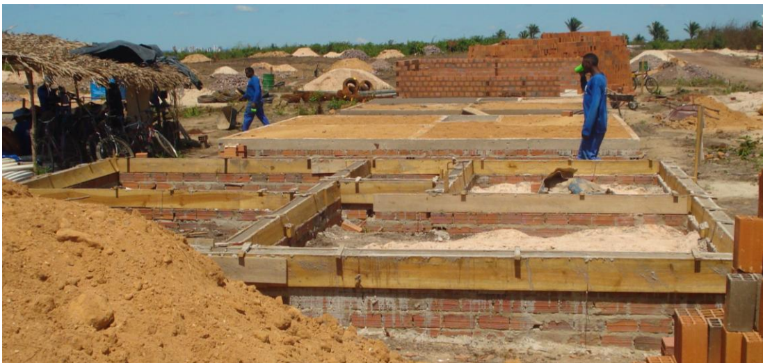
Figura 3.8.3 Utilização de formas de madeira. Fonte: ADH (julho/2009)
