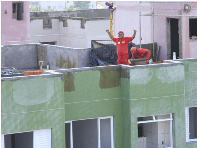
Figura 2.9.14 Reparo do revestimento de pastilhas de vidro. Fonte: Deangelo Fotos: RUBENS LARA 02-04-2011. Disponível em: http://deangelofotos.blogspot.com.br/2011/04/rubens-lara-02-04-2011.html . Acesso em 02/05/2012.
