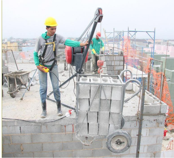
Figura 2.9.6 Blocos de concreto para alvenaria estrutural. Fonte: Deangelo Fotos: RUBENS LARA 30-07-2010. Disponível em: http://deangelofotos.blogspot.com.br/2010/07/rubens-lara-30-07-2010.html . Acesso em 02/05/2012.
