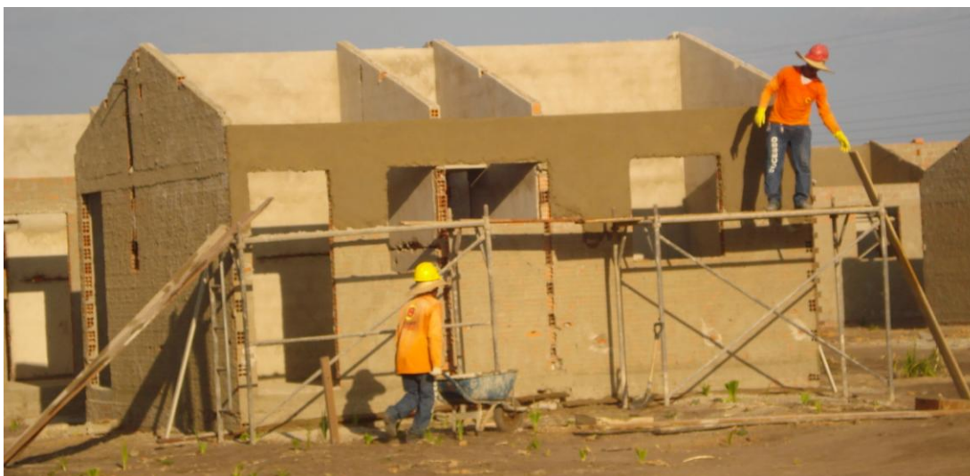
Figura 3.8.6 Execução do revestimento argamassado sobre blocos cerâmicos. Fonte: ADH (julho/2009)
