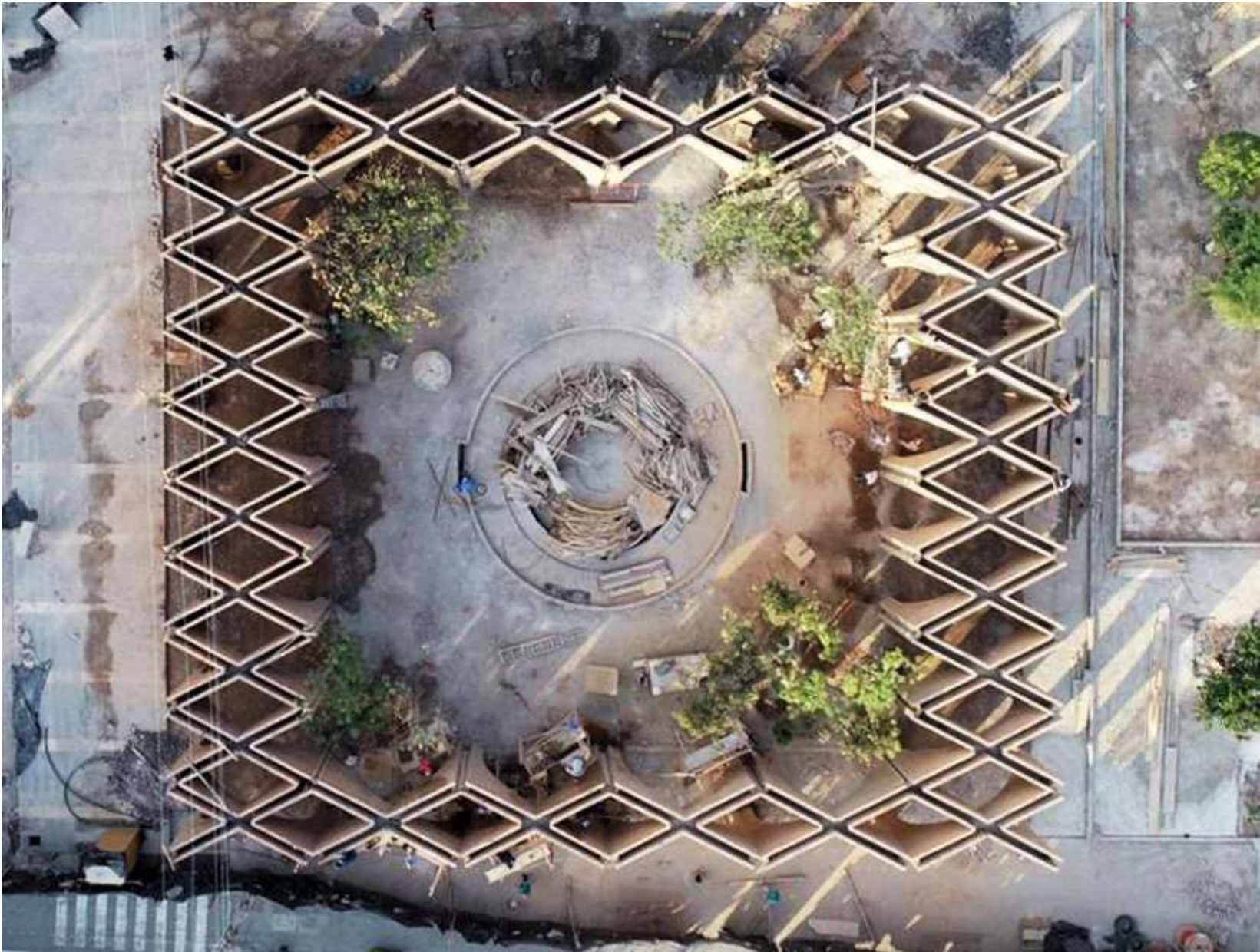
Foto aérea da praça em obras (2018). Estúdio MMX.
