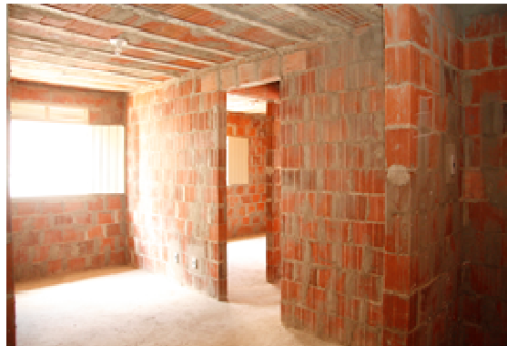
FIGURAS 14 e 15 – Fotos durante a execução da obra. Fonte: Prefeitura de Fortaleza, 2013.
