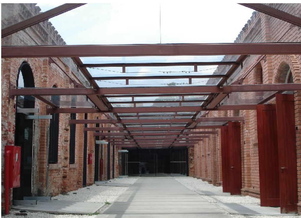
Foto 5- Vista interna do galpão central com as tesouras de aço. Foto 6 - Vista da passarela entre os galpões com o piso de concreto e de pedrisco. Fonte: PISANI, Maria Augusta Justi (2008).
